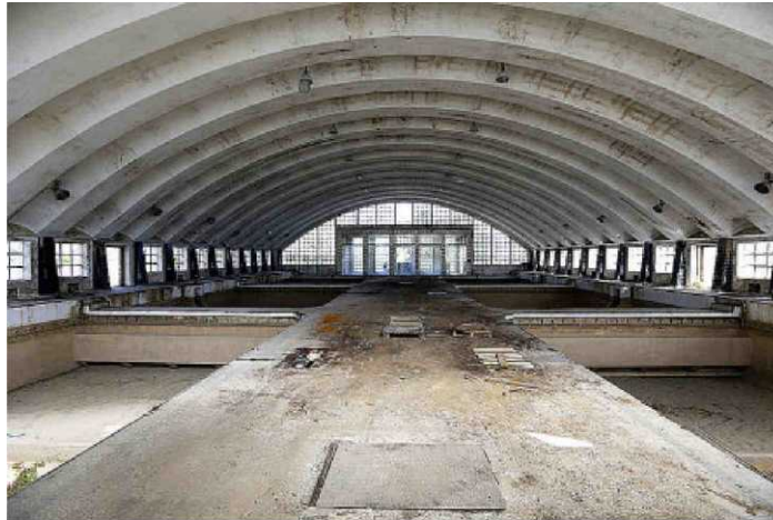
El interior de la depuradora destaca por ser luminoso y diáfano. / TRUCHUELO
